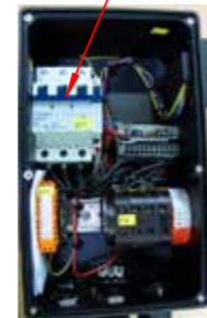
motor aşırı yük koruma şalteri
